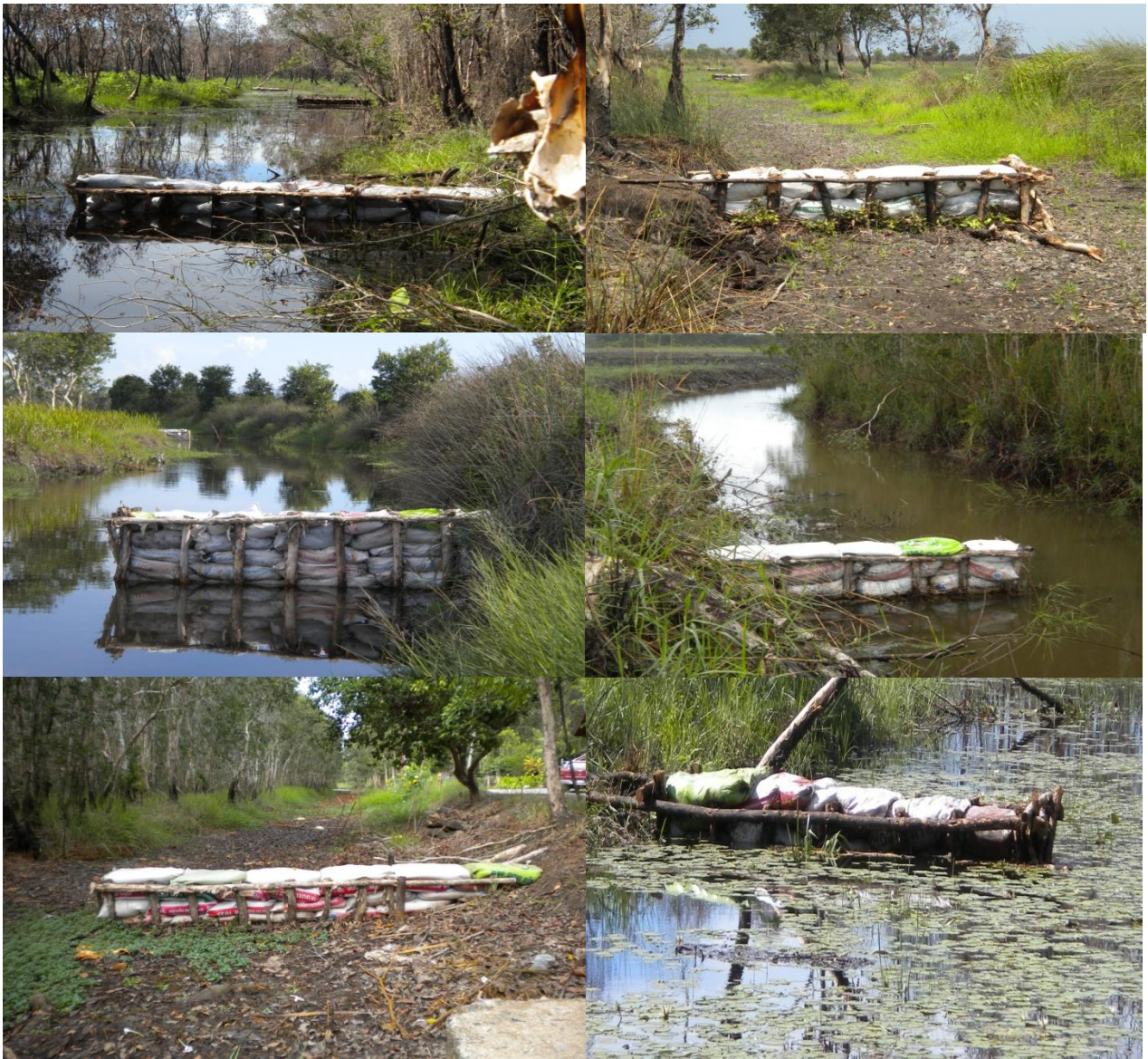
ภาพแสดงฝายชะลอการไหลของน้ำในพื้นที่ป่าพรุ
